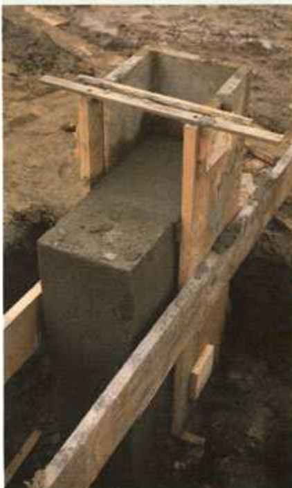
↑ Wykonanie fundamentów najlepiej zlecić tej samej firmie, która będzie stawiać dom
