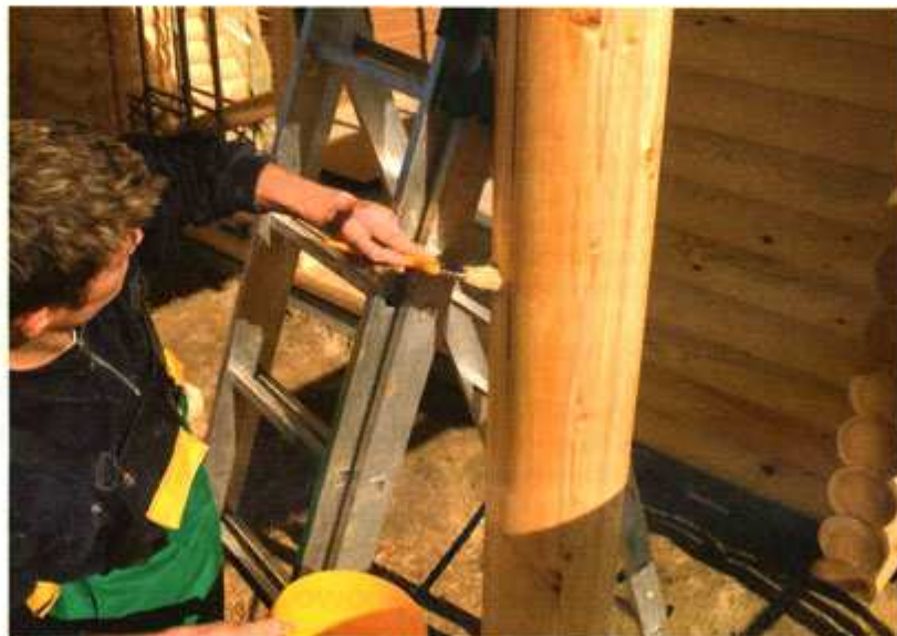
↑ Ściany z bali wymagają polakierowania lub pomalowania impregnatem dekoracyjnym
