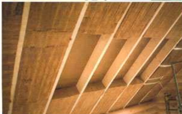
← Zarówno połacie, jak i ściany szczytowe robione w konstrukcji szkieletowej trzeba ocieplić, aby zagwarantować im odpowiednią izolacyjność termiczną
