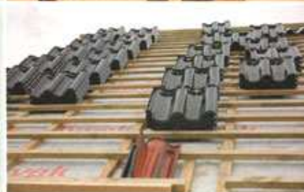
↑ Na zaizolowanym przeciwwilgociowo i ocieplonym dachu można rozpocząć układanie pokrycia
