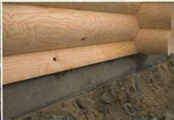
← Bale podwalinowe, czyli te, które opierają się na fundamencie, muszą być do niego zakotwione
