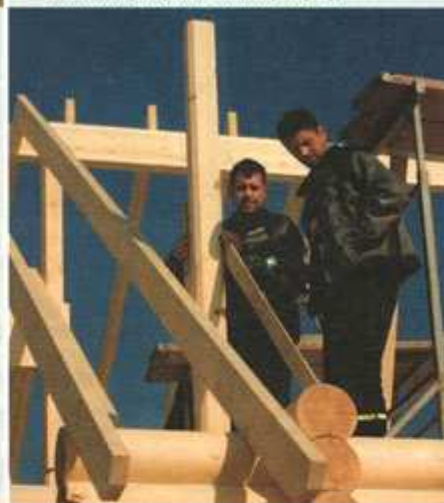
↓ Krokwie znajdują oparcie na balach oczepowych, które pełnią taką samą funkcję jak murłata (drewniana belka montowana na ścianach murowanych przed budową więźby)
